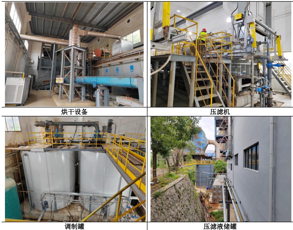
图 2-1 项目现场情况图片
